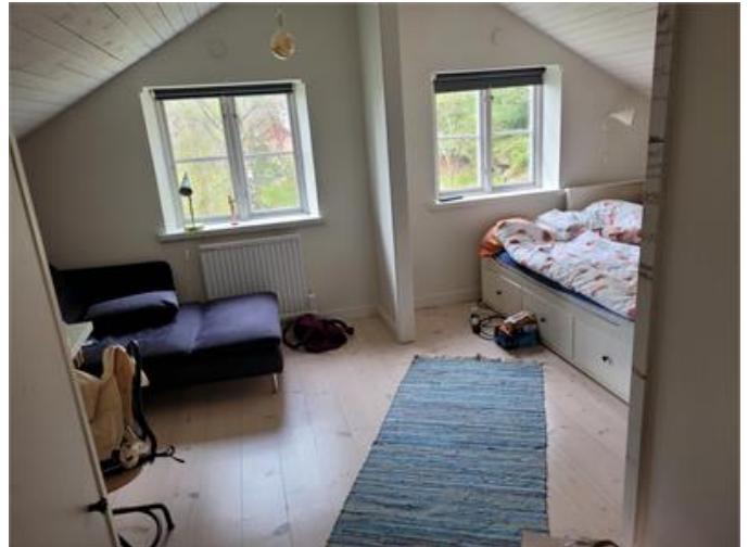
Trasigt fönster i sovrum.
