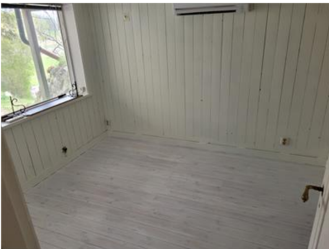
Uppreglade golv och utreglade väggar med förhöjda fuktvärden.
