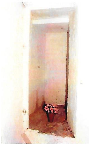
Staketgatan 3, källaren. Ett av utrymmena för buttar från klosetterna. Foto: P. Ohlsson 2004
