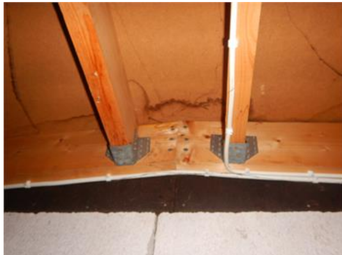
Yttertaketets insida i förråd.
