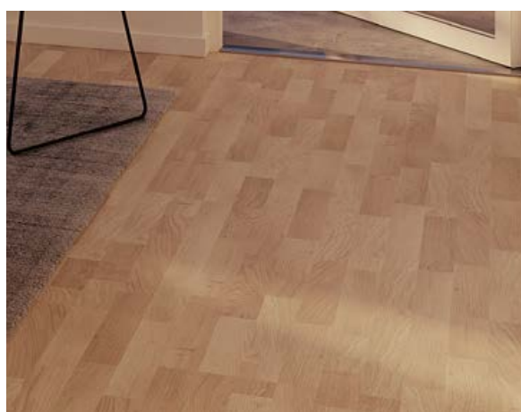
GOLV – Originalgolvet är en 3-stavig, vitlaserad askparkett. Parketten har en mattlack som ger ett oljat utseende, men som är lika hållbart som traditionell lack.
