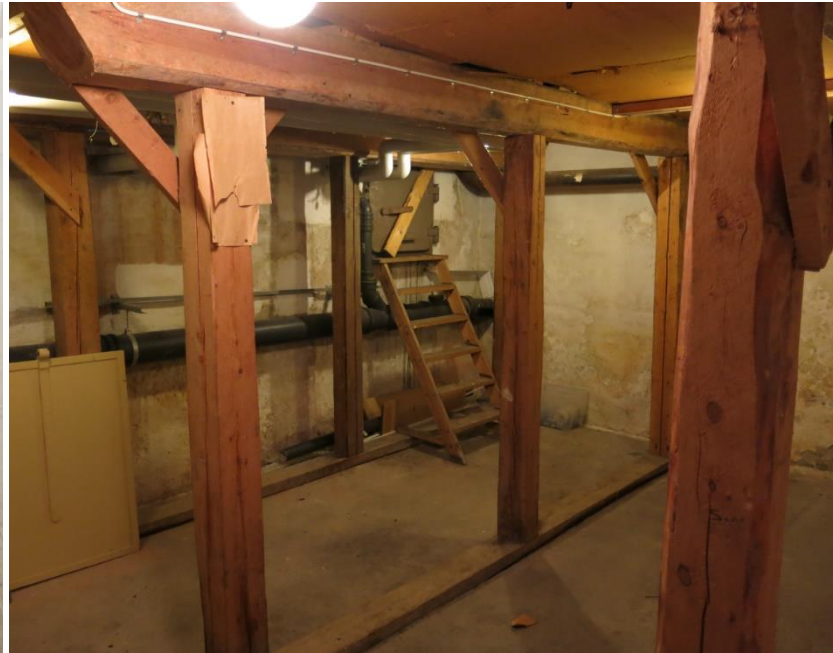
Skyddsrum med trästämp.
