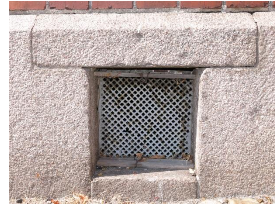
Skråkantad granitsockel med äldre ventilgaller.
