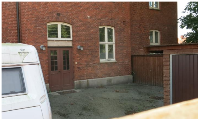
Asfalterad yta med garage i norr.
