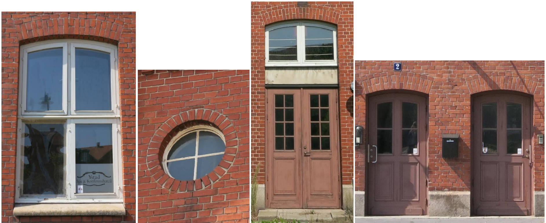
Fönster med välvt överstycke och tvärpost vid mitten. Ursprungligt runt (gjutjärns?) fönster på gavelspets. Glasad pardörr med överljus på sydgaveln samt enkeldörrar mot kaserngården.
