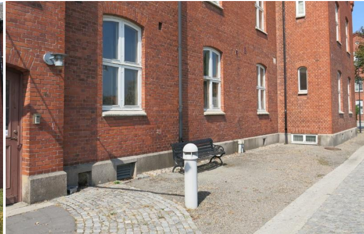
Gatsten, betongsten och grus mot f.d. kaserngården.
