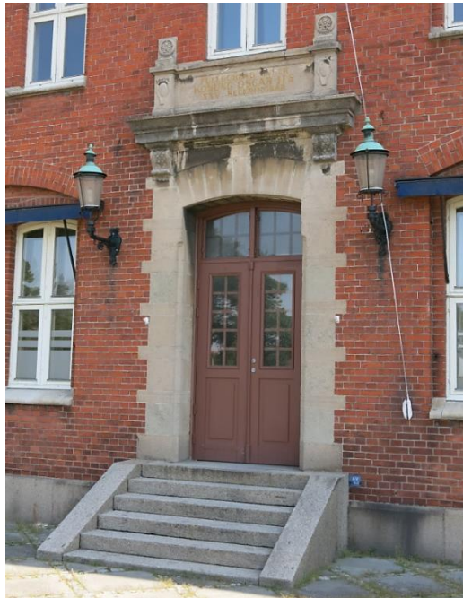
Huvudentré med trappa av krysshamrad granit och dörromfattning av ornamenterad kalksten.
