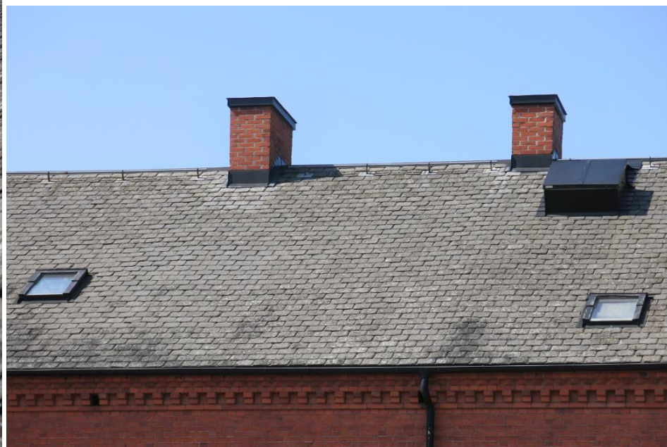
Takfönster, uppstigningslucka och skorstenar.
