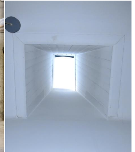
Ljusbrunn i taket mittersta trapphuset.
