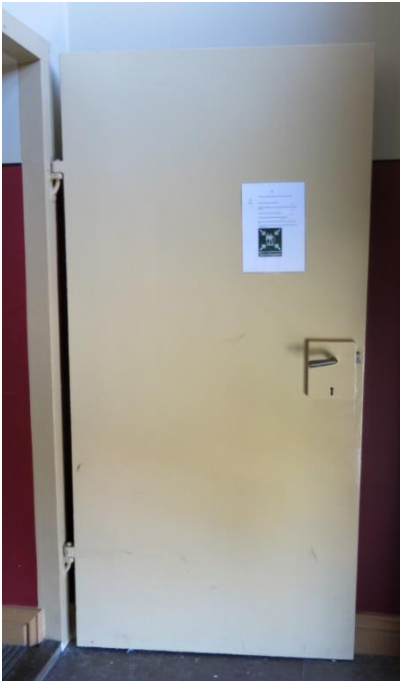
Pansardörr i trapphus.
