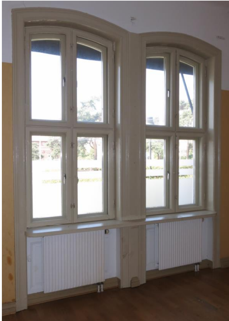
Ursprungliga innerbågar och högklassiga snickerier i form av foder, socklar, paneler etc.
