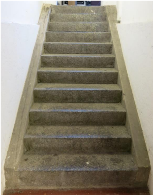
Källartrappa av krysshamrade granitblock.
