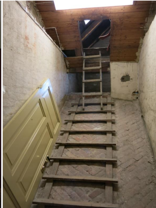
Vind innanför mittpartiet mot kaserngård.
