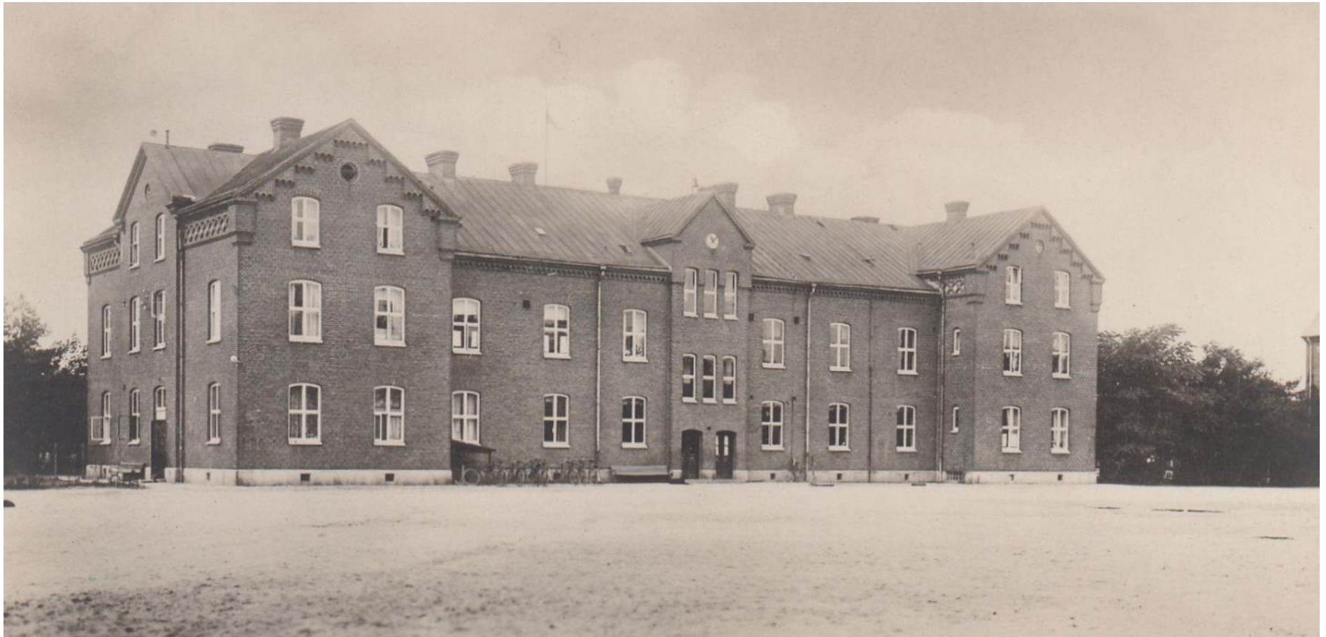
Östfasaden. Taken är vid tiden för fotot belagda med falsad plåt. När taken belades med nuvarande skiffertäckning är okänt. YMHM.
