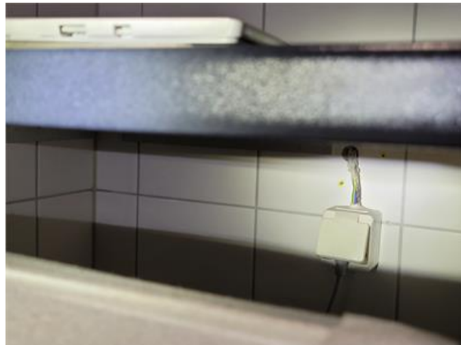
Öppen elinstallation i våtrum på övre plan
