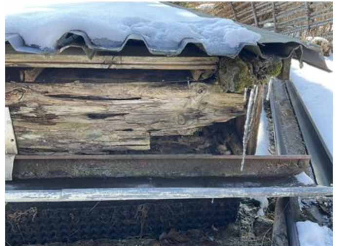
Takfot till garage
