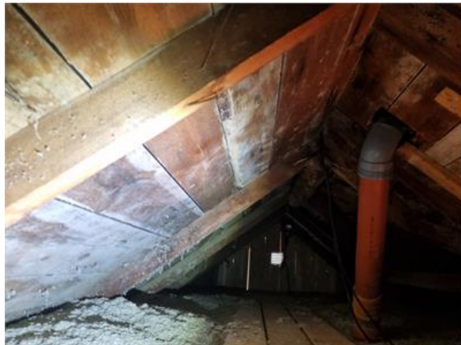
Vind med mikrobiell påväxt
