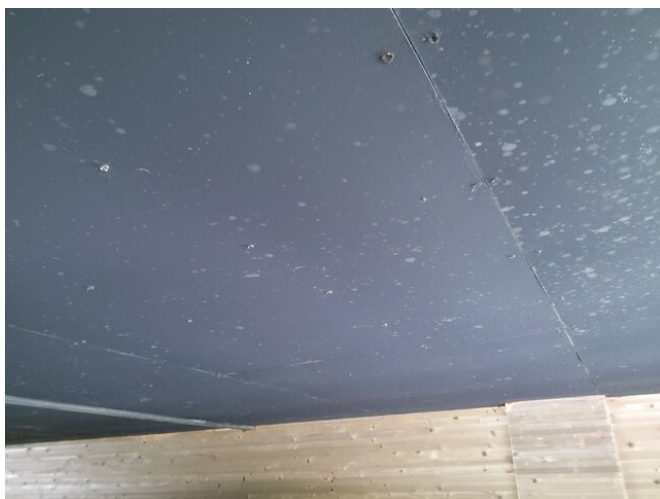
Fläckar av smuts på blindbottenskiva.
