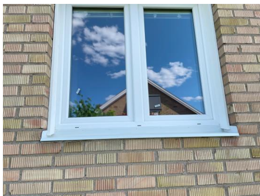
1 fönster med isolerglas (ädelgasfyllning)
