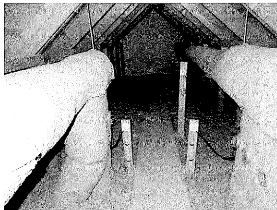
Bild 14 Spång och ventilationsrör på vind
