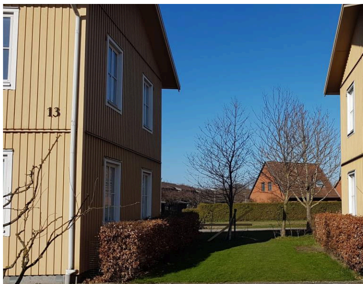
Kulvertar ligger dragna ca 1 m ner i marken.
