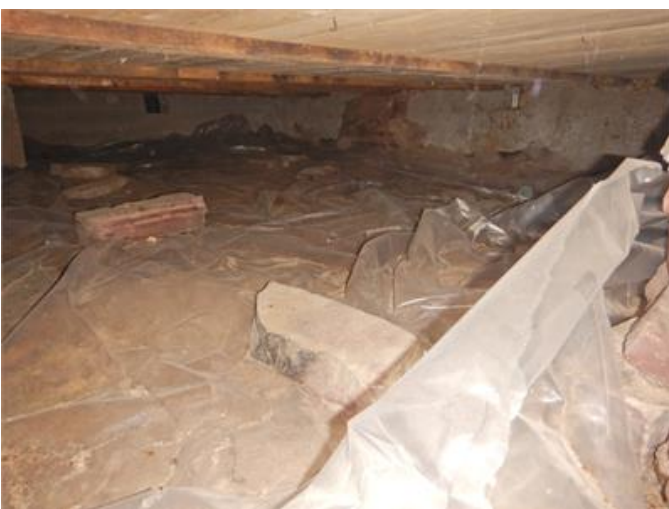
Bjälklag under kök
