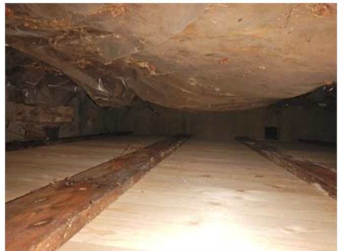
Undersida av bjälklag under sovrum.
