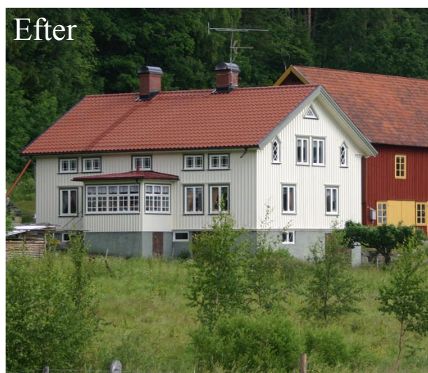
Gården Furuberg 2:3 har genomgått en varsam renovering. Fasaden och fönsterfoder har ny traditionell färgsättning, taket är klätt med rött lertegel och rökgångarna har murats om. Många av byggnadens fönster är bevarade.
