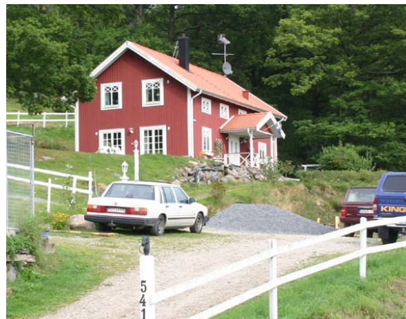
Det är ur kulturmiljösynpunkt viktigt att anlägga ny bebyggelse med anpassning till platsens naturliga förhållanden. Vid Dalagården har en naturlig avsats i landskapet fungerat bra för uppförandet av ny byggnad.
