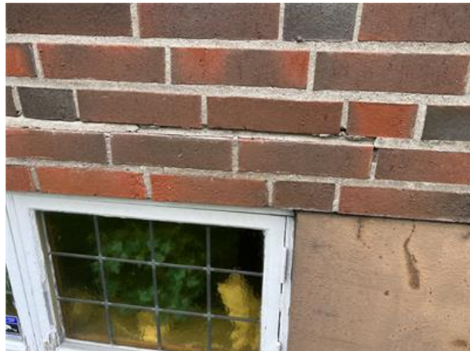
Fasad, fogar släpper lokalt på södersidan.
