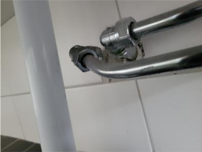
Rör genomföring i vägg under komod
