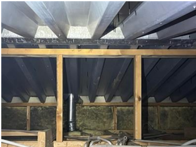
Bild från vindsutrymmet
