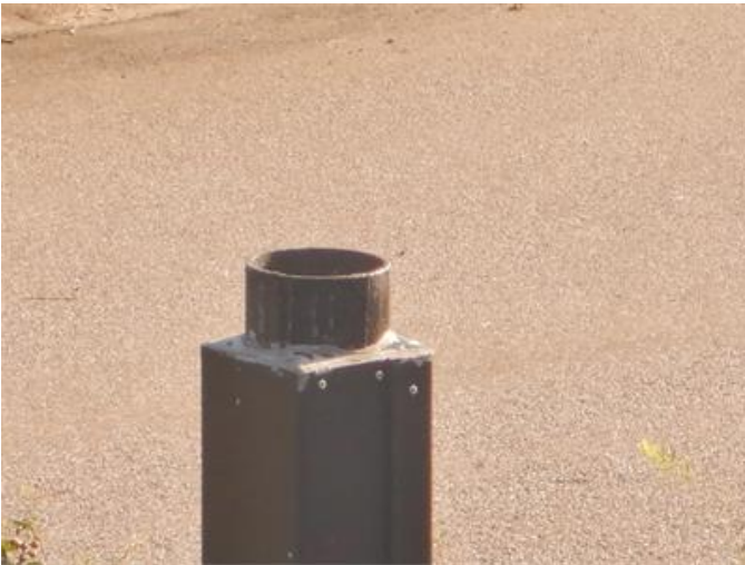
Överdel av genomföring avloppsluftning tätad med mjukfog.
