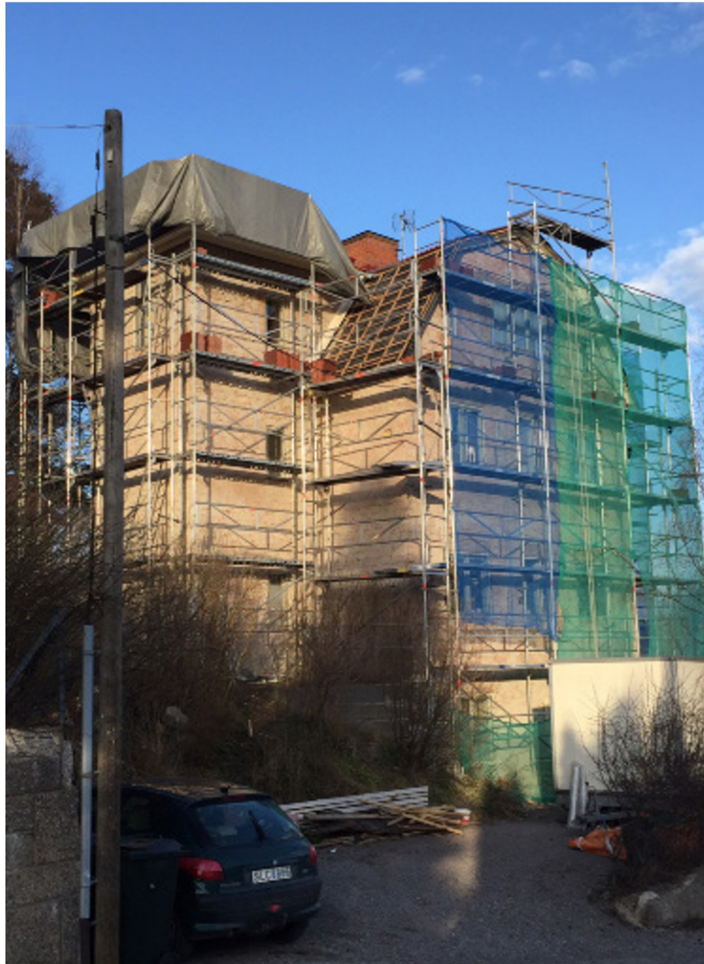
Den stora fasadrenoveringen 2015, här huset utan puts.
