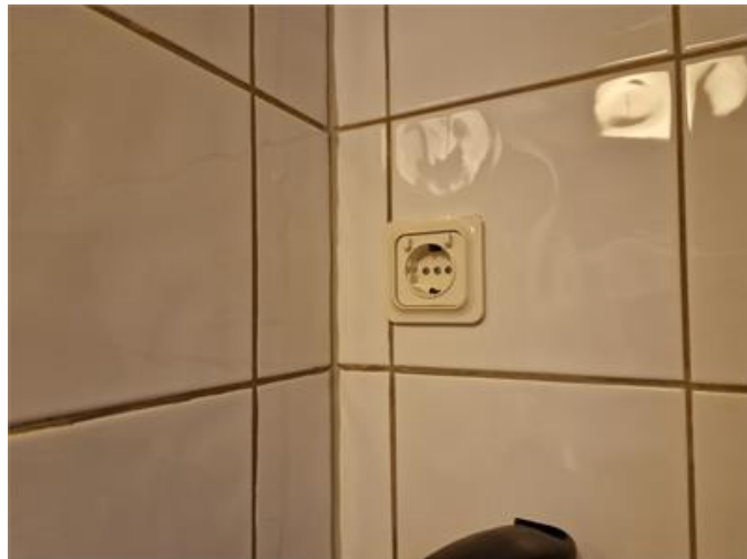
Övre plan/Dusch, Wc: Trasigt lock till eluttag noterades.
