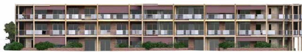
Hus B, fasad mot väster (gatan)
