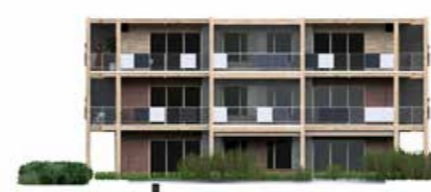
Hus A, fasad mot sydväst (torget)
