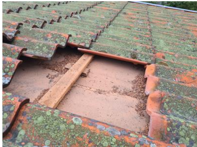
Tak, underlagstak av träfiberskivor.
