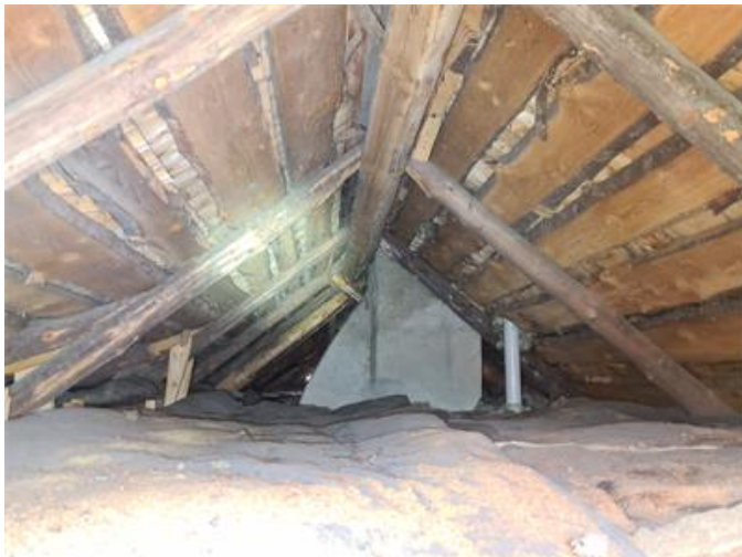
Nockvind, översiktsbild från luckan.
