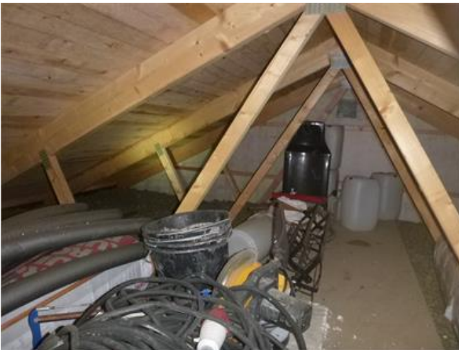
Bilden visar vy av vind (garage).
