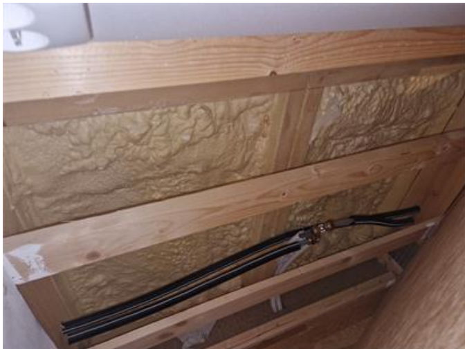
Rör/vattenkopplingar bakom väggskiva
