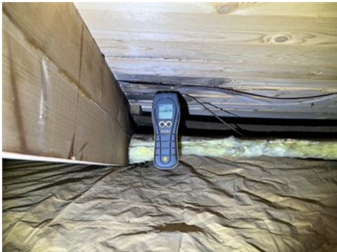
Fuktmätning på vind.
