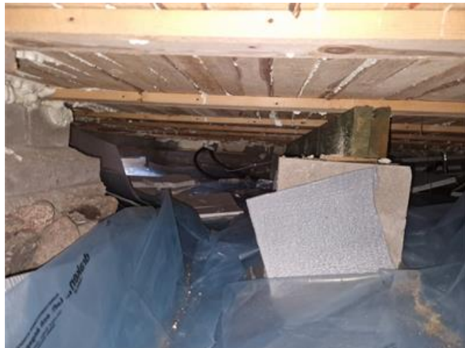
Vy i kryppgrund under ursprungsbyggnad
