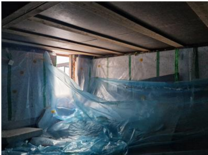
Vy i kryppgrund under tillbyggnad
