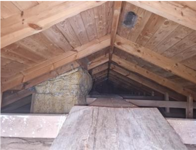
Vy på vindsutrymmet
