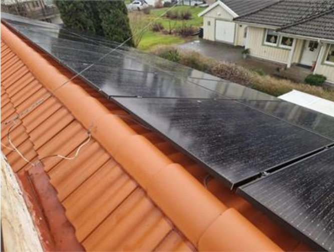
Vy på yttertak med solceller
