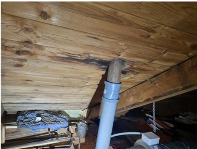
Genomföring för avluftning avlopp, vy från vind.
