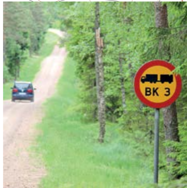
Rätt bärighet på vägarna är en förutsättning för att hela Gnosjö kommun skall kunna leva och utvecklas.
