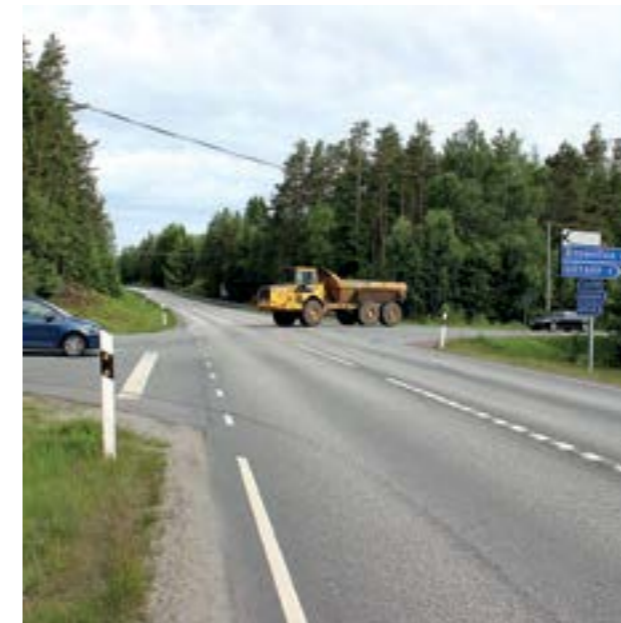
Korsningen väg 151 och 623 (Götarpskrysset) måste förbättras.
