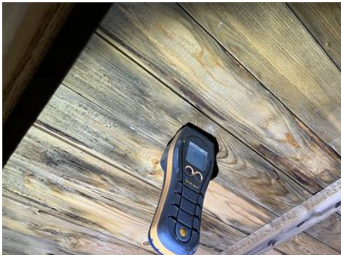
Fuktmätning på kattvind
