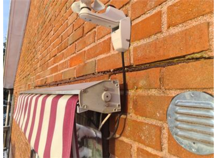
Fasad Tegel, släpp och blottat armering på gavel.
