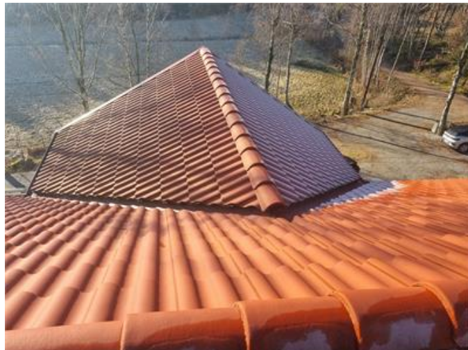
Bilden visar del av yttertaket.
