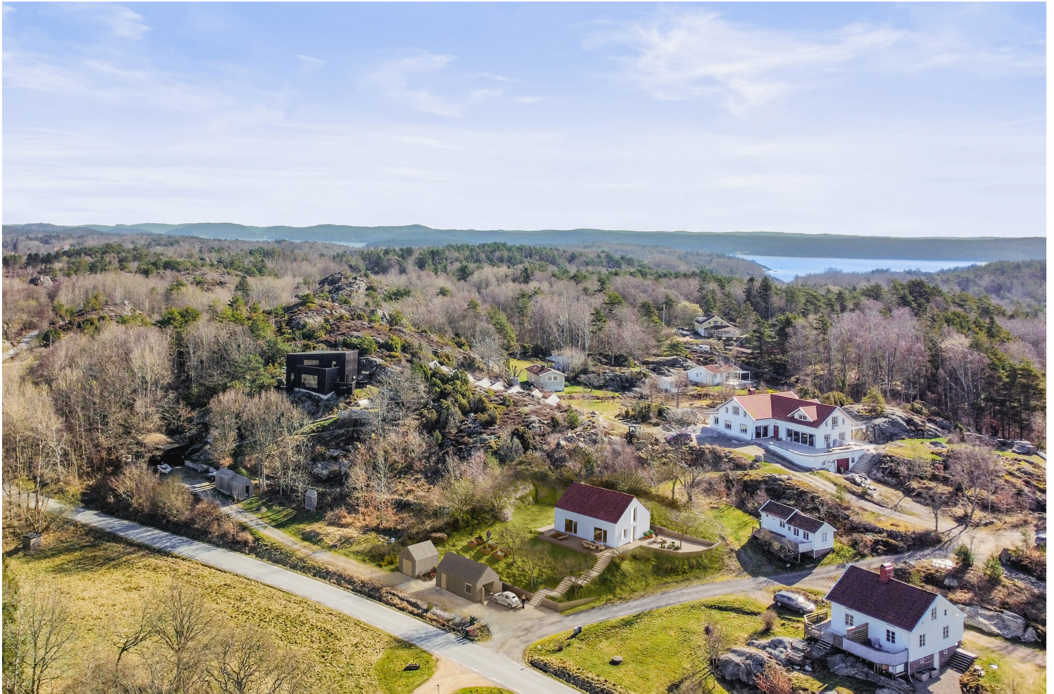
Byggnaderna sett från vägen. Rendering av Radar arkitektur.
