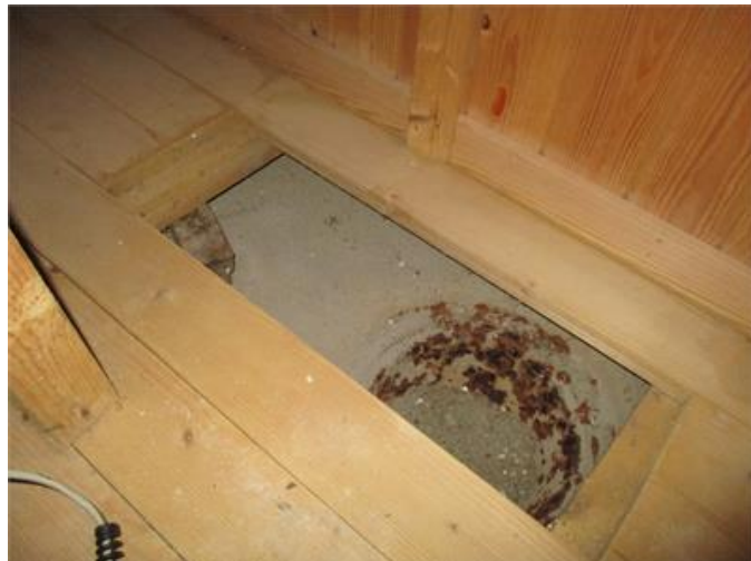
Uppreglat golv i bastu
