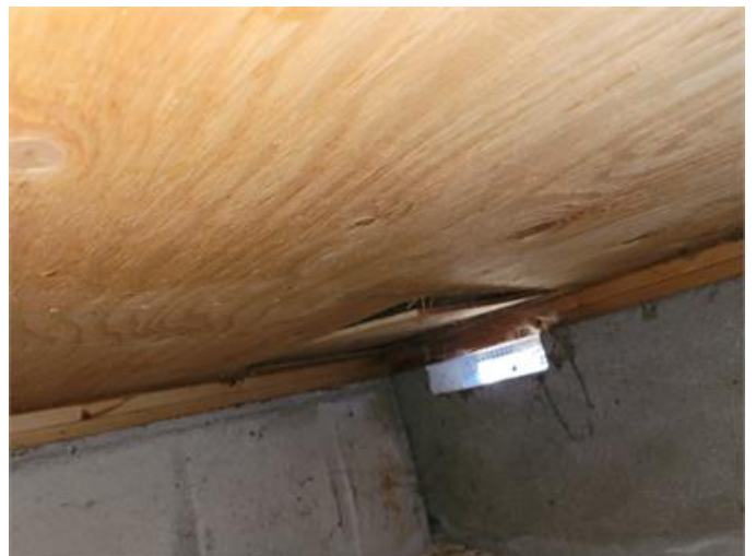
Blindbottenskiva har släppt från sitt underlag.
