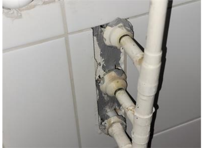
Otätheter invid rör genomföring i badrum
