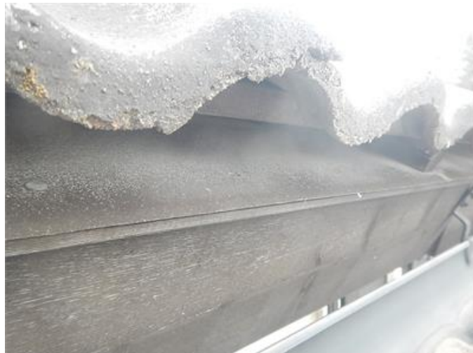
Takfotsplåtar ej monterade.
