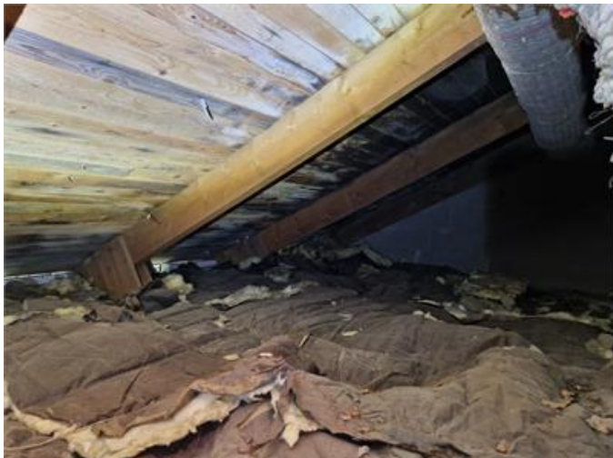
Vy på vindsutrymmet
