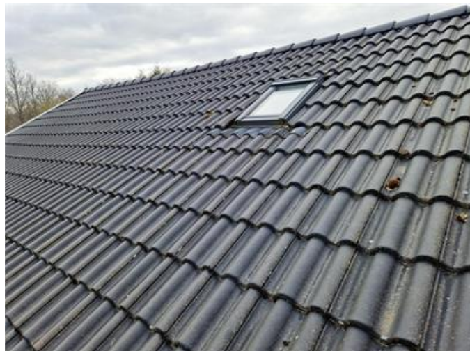
Vy på yttertak
