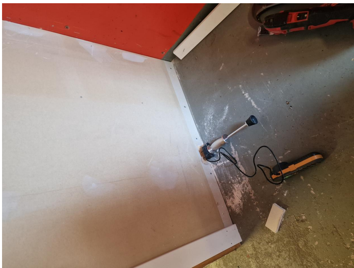
Fuktmätning i mellanväggsyll.
