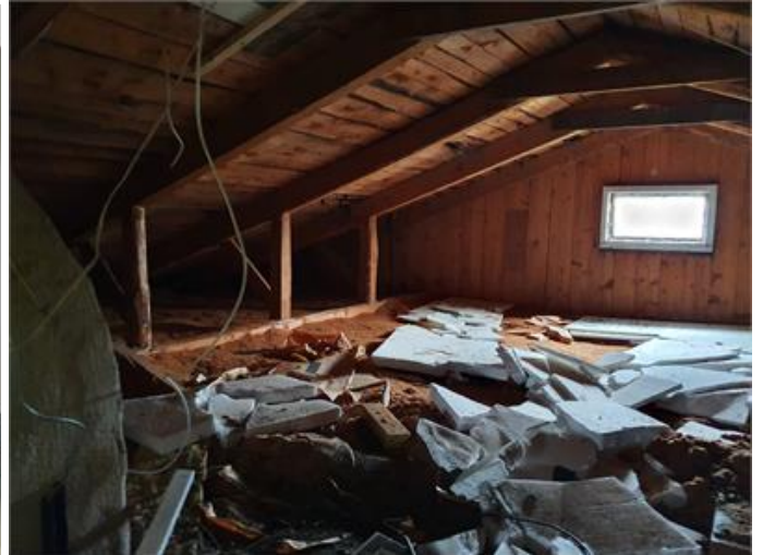
Utrymmet på vinden
