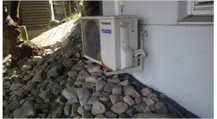
Luftvärmepumpen monterad på grundmuren
