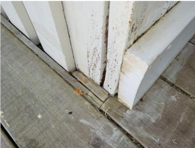
Rötskadad fasadpanel
