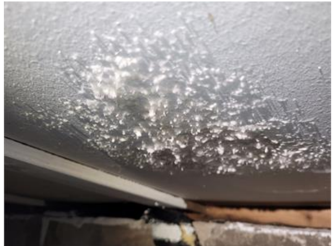
Mikrobiell påväxt på blindbotten (Gästhus)
