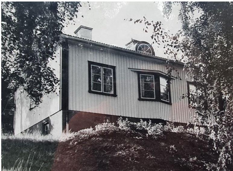
Äldre bild av huvudbyggnaden som visar lunettformad takkupa på dess östra fasad.
