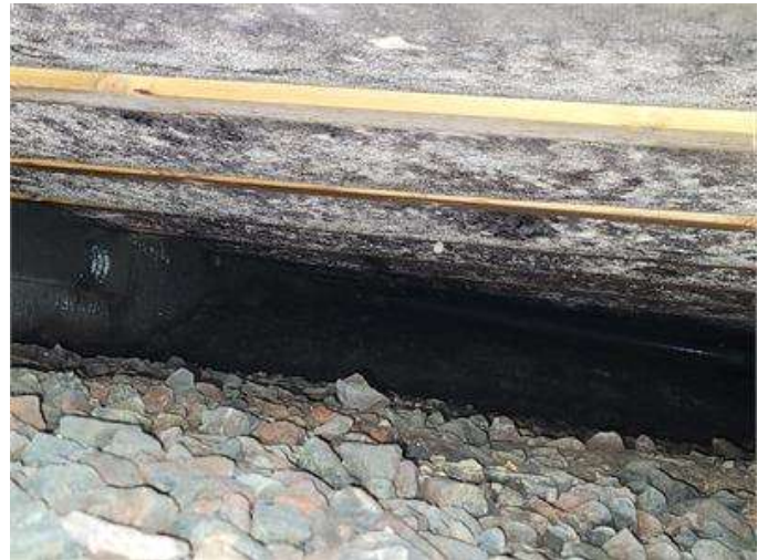
Kondens utfällning på blindbotten
