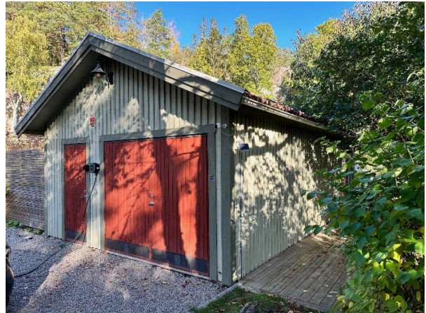
”Sekundär byggnad / garage”
