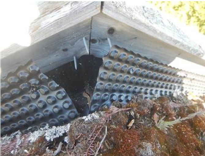
Platonmatta som ej är täckt av torv och ej ansluter mot vindskiva.
