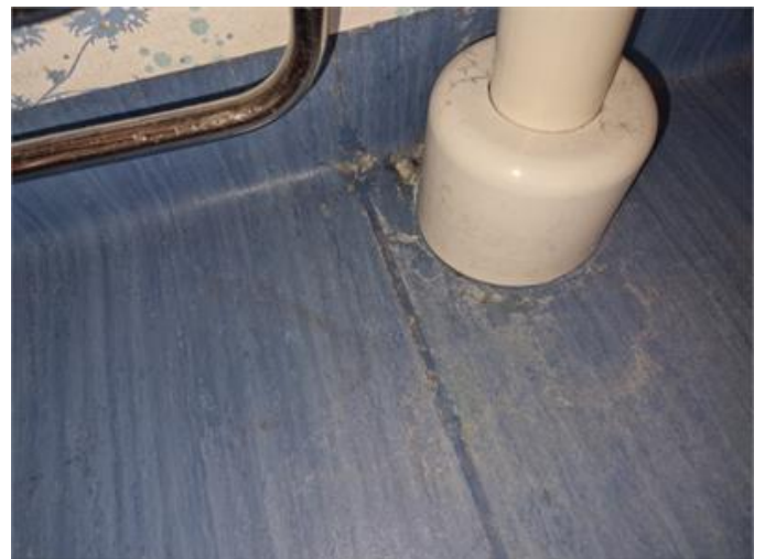
Äldre våtrum har otätheter i ytskiktsskarvar.
