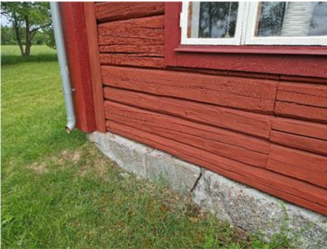
Grundmur och fasad.
