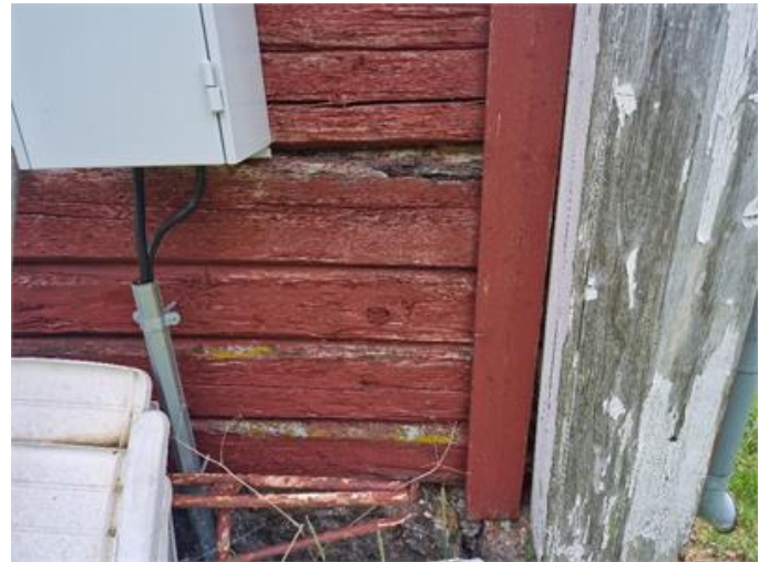
4e stocken på gavel (B4) är rötskadad och delar behöver bytas ut.
