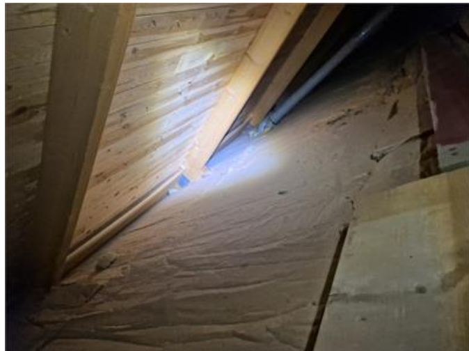
Vy på vindsutrymmet
