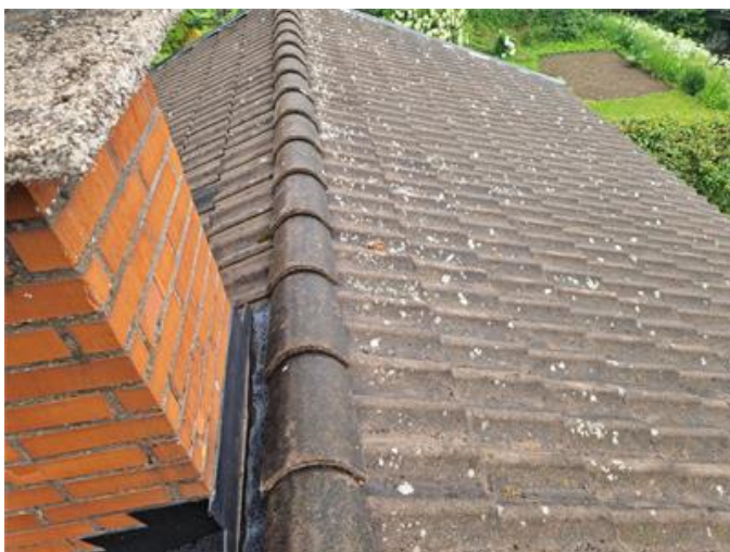
Vy på yttertak
