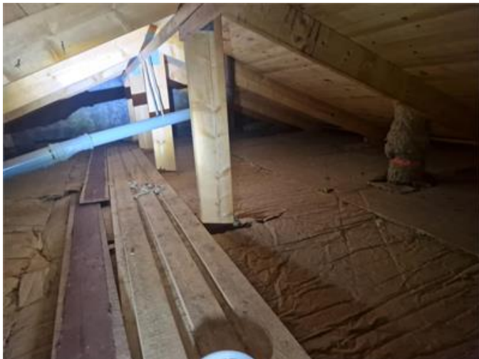
Vy på vindsutrymmet
