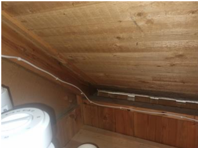
Översiktsbild, underlagstak. Vy från sidovind.
