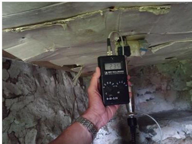
Fuktmätning i grund ett
