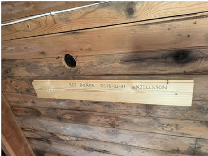
Referensbräda som monterats på vindsutrymmet.
